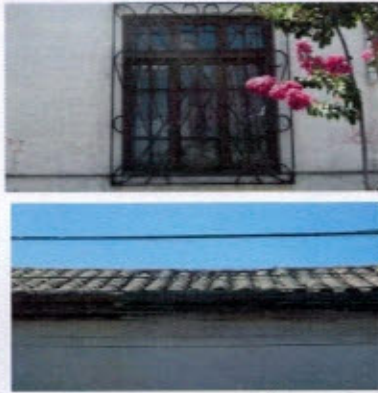
Fotografías de la tecumbre con tejas de arcilla, aleros cortos de madera, puertas y ventanas con perfilera de madera y molduras decorativas.
