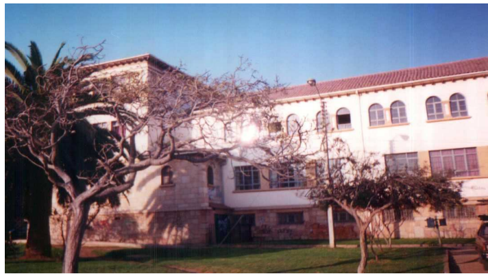
VISTA DESDE RUTA 5 SUR
