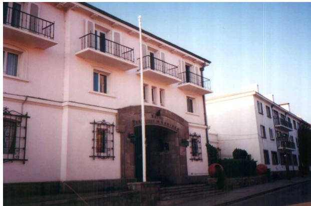
ACCESO POR CALLE CORDOVEZ
