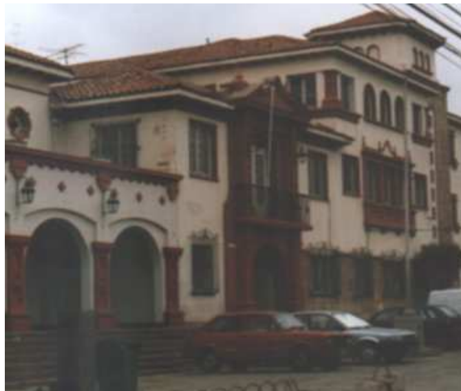
DETALLE DE LA FACHADA PRINCIPAL
