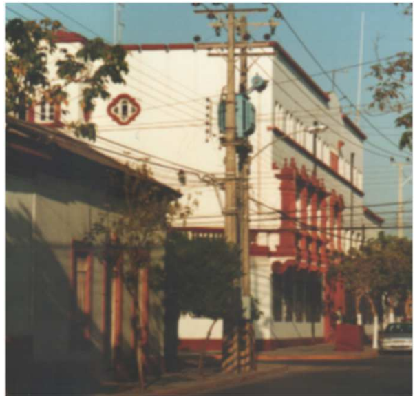
FACHADA A CALLE COLON
