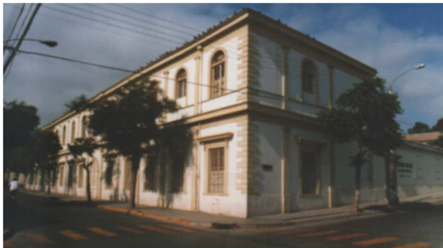
FACHADA A CALLE RODRIGUEZ
