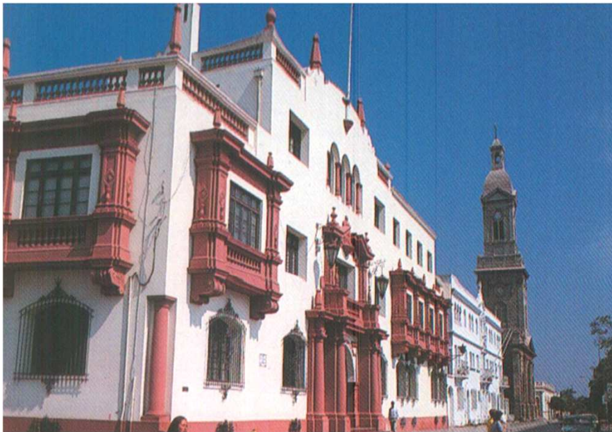
FACHADA A CALLE LOS CARRERA
