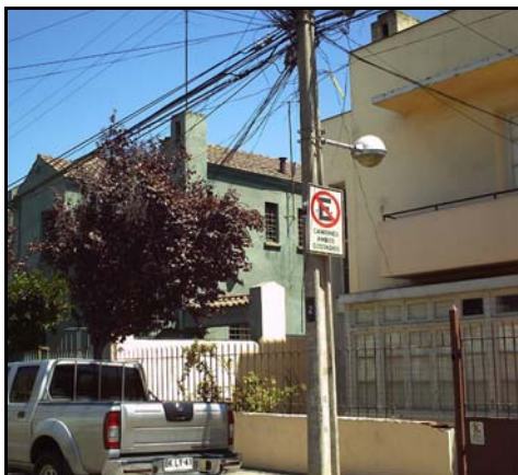
Fotografía de fachada
