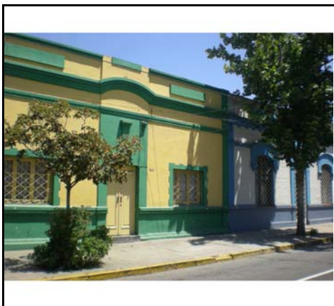
Fotografía de fachada
