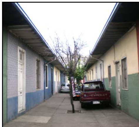
Fotografía de fachada
