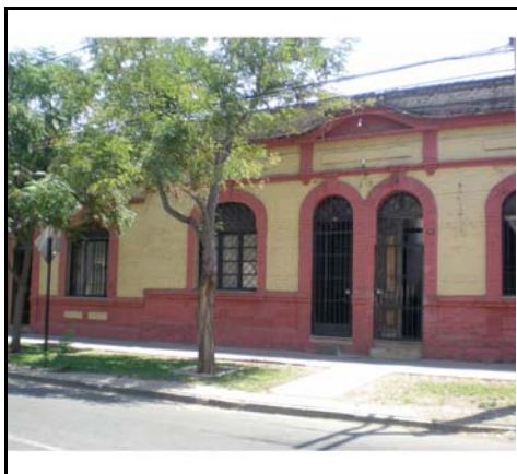
Fotografía de fachada
