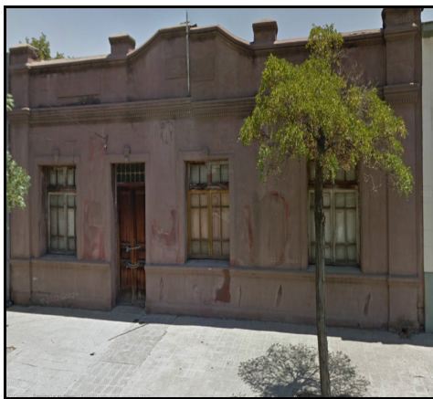
Fotografía de fachada
