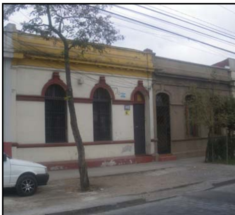
Fotografía de fachada
