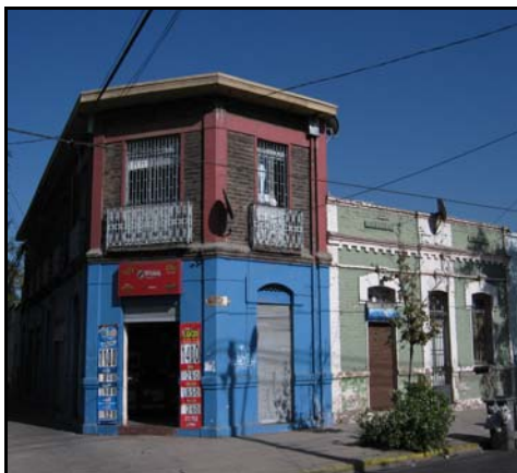
Fotografía de fachada
