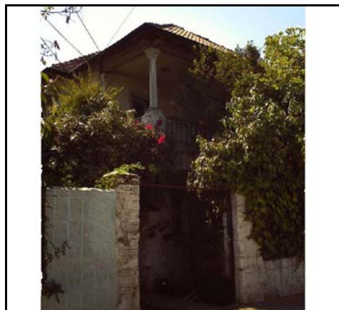
Fotografía de fachada
