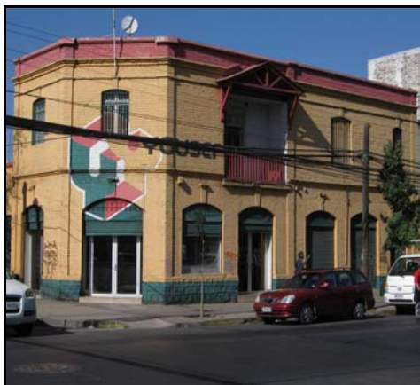
Fotografía de fachada
