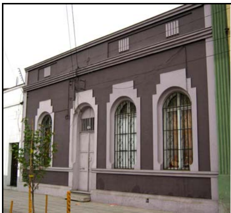
Fotografía de fachada
