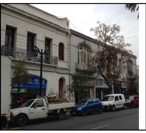
Fotografía de fachada
