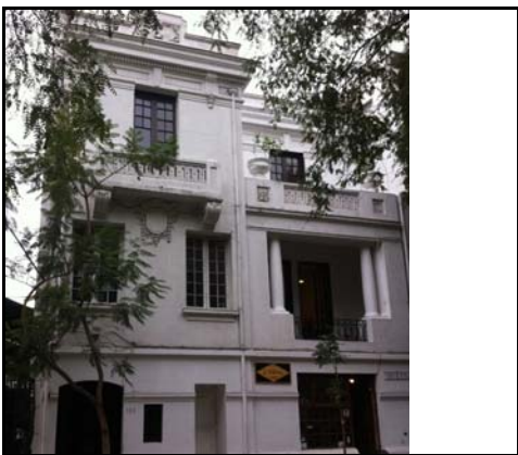
Fotografía de fachada
