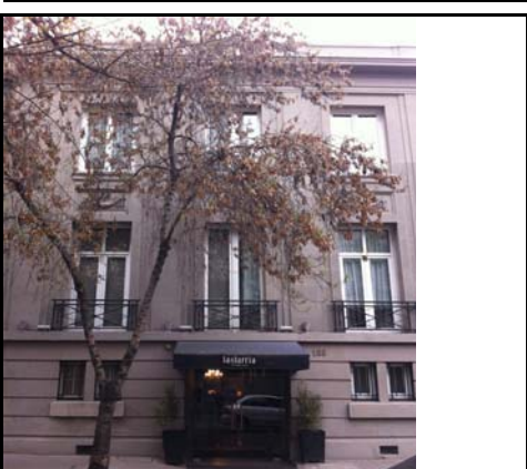
Fotografía de fachada
