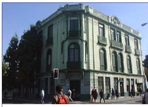
Fotografía de fachada
