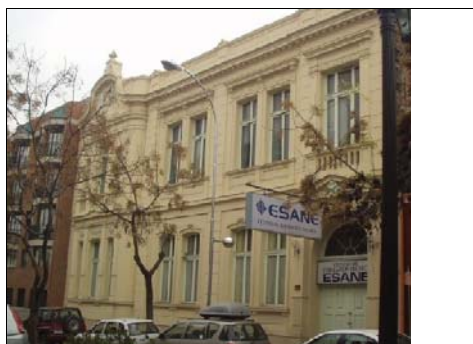
Fotografía de fachada
