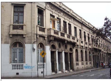
Fotografía de fachada
