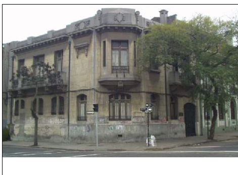
Fotografía de fachada
