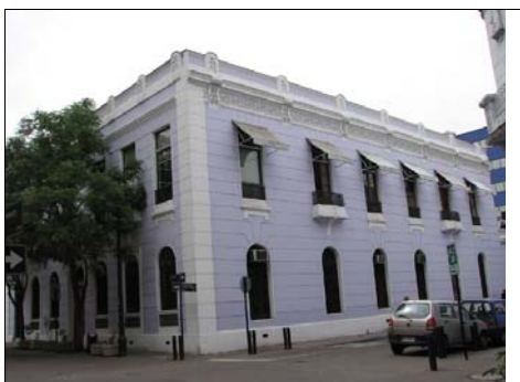
Fotografía de fachada
