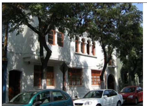
Fotografía de fachada
