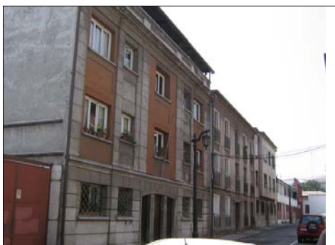
Fotografía de fachada
