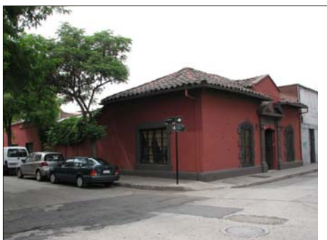
Fotografía de fachada
