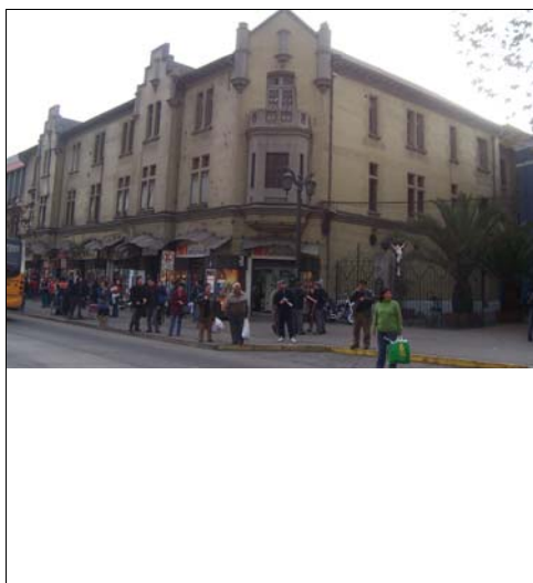
Fotografía de fachada
