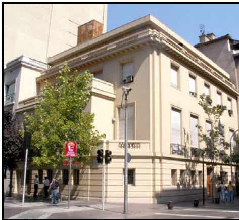
Fotografía de fachada
