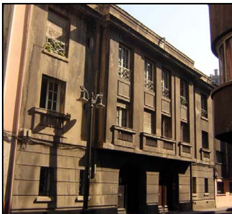
Fotografía de fachada
