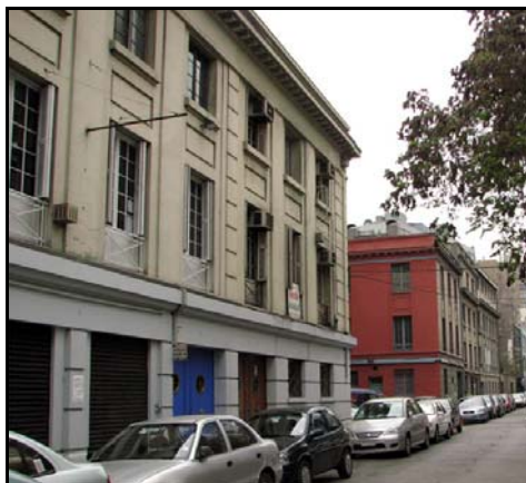
Fotografía de fachada
