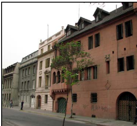
Fotografía de fachada
