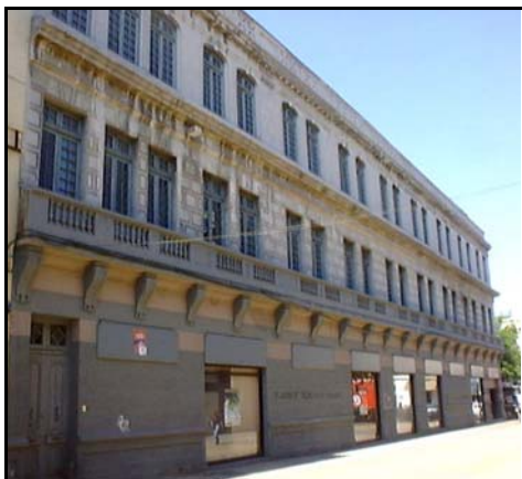
Fotografía de fachada
