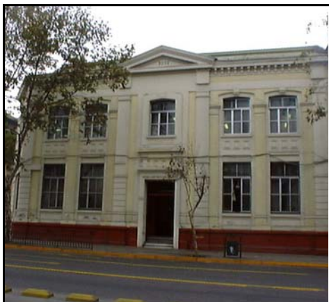
Fotografía de fachada
