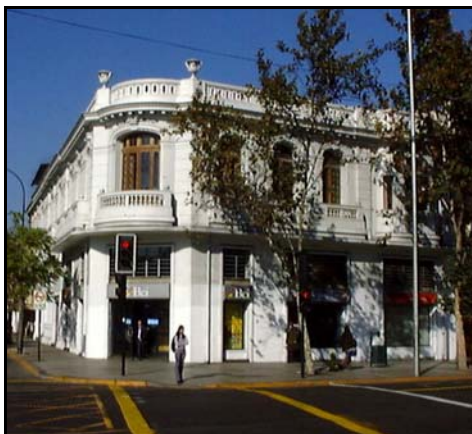
Fotografía de fachada
