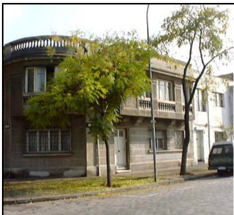
Fotografía de fachada
