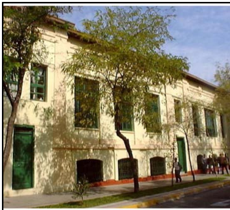
Fotografía de fachada
