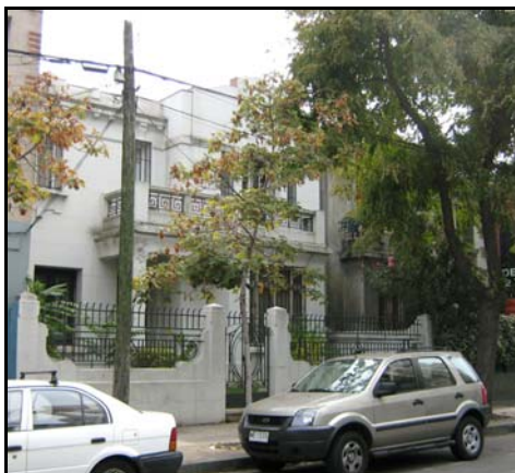
Fotografía de fachada
