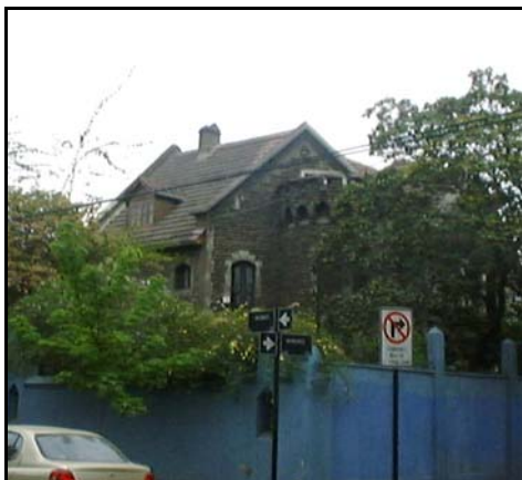
Fotografía de fachada
