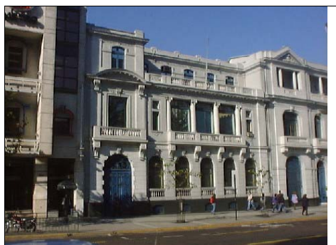
Fotografía de fachada
