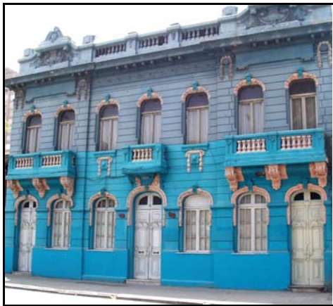
Fotografía de fachada
