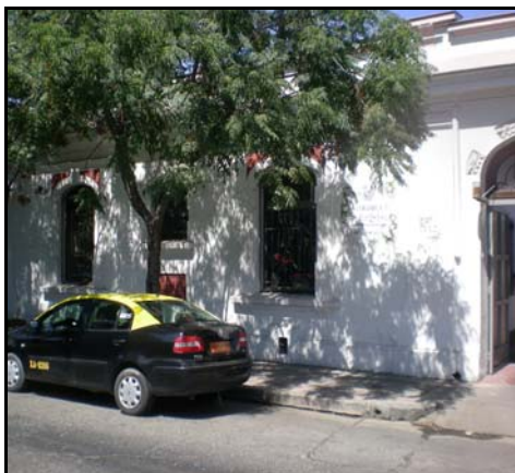
Fotografía de fachada
