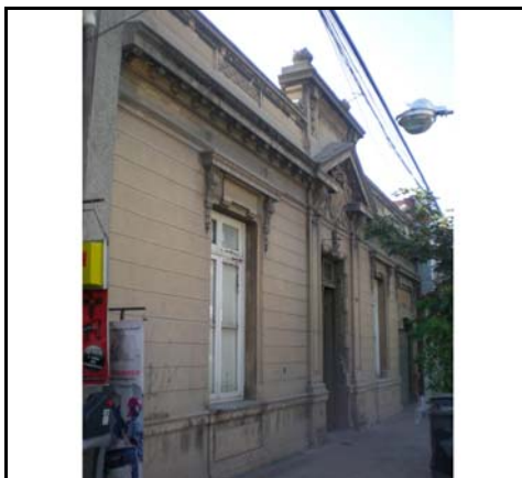
Fotografía de fachada
