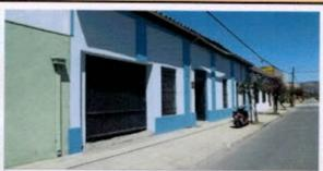
Fotografías de la tecumbre con tejas de arcilla, aleros cortos de madera, puertas y ventanas con perfilería de madera, molduras decorativas que denotan la estructura.
