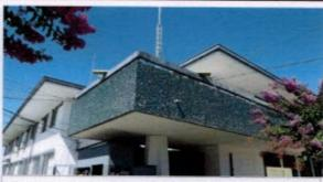
Fotografías de volumenes simples y continuos suspendidos sobre pilares de hormigon en cruz,, revestidos con azulejos, además de vanos salientes.
