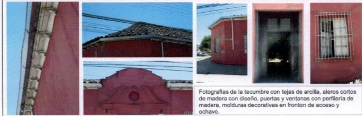
Fotografías de la techumbre con tejas de arcilla, aleros cortos de madera con diseño, puertas y ventanas con perfilera de madera, molduras decorativas en fronton de acceso y ochavo.
