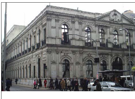
Fotografía de fachada
