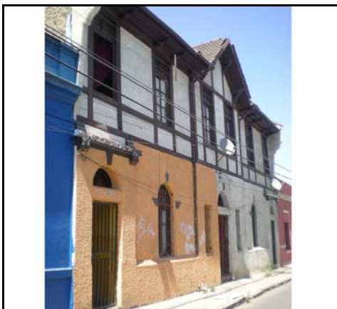
Fotografía de fachada
