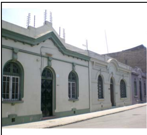
Fotografía de fachada
